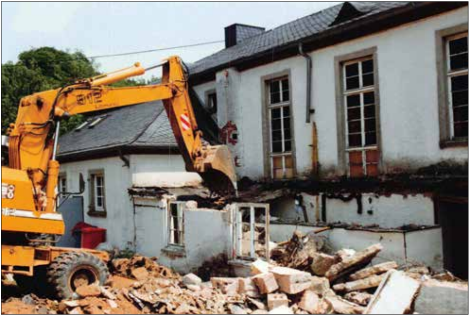
Abrissarbeiten an der Jahnturnhalle im Jahr 1997
