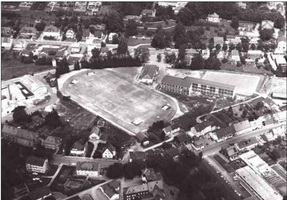
Die Jahnturnhalle - damals noch umgeben vom vereinseigenen Sportplatz - rechts die Grundschule
